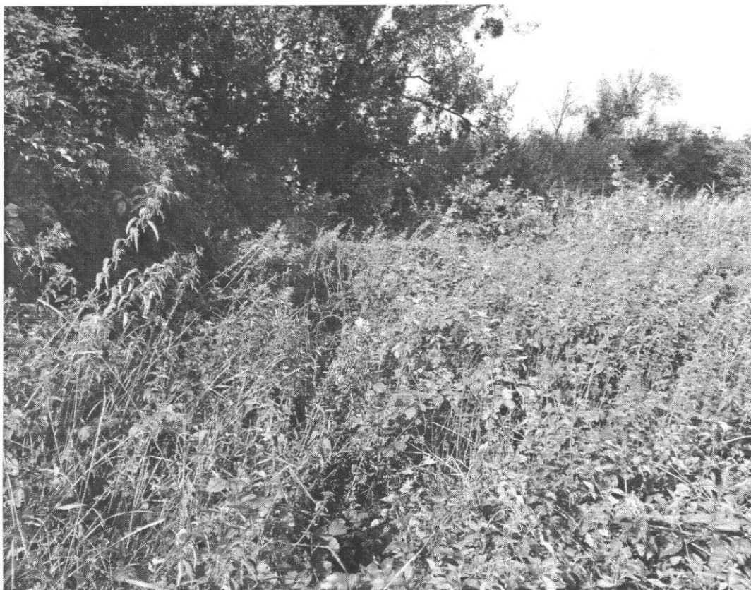
Obr. X.3. Kanál Sirmík (ev. č. 5 412 075 001)
